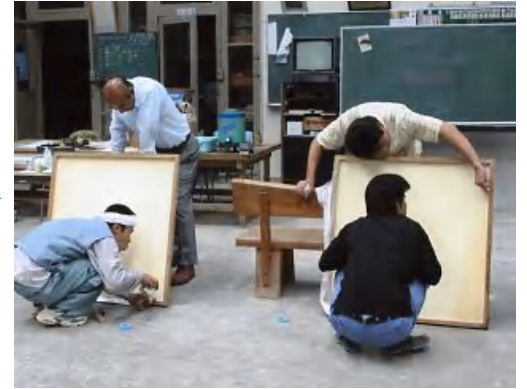
ボンタイル側面養生を指導
